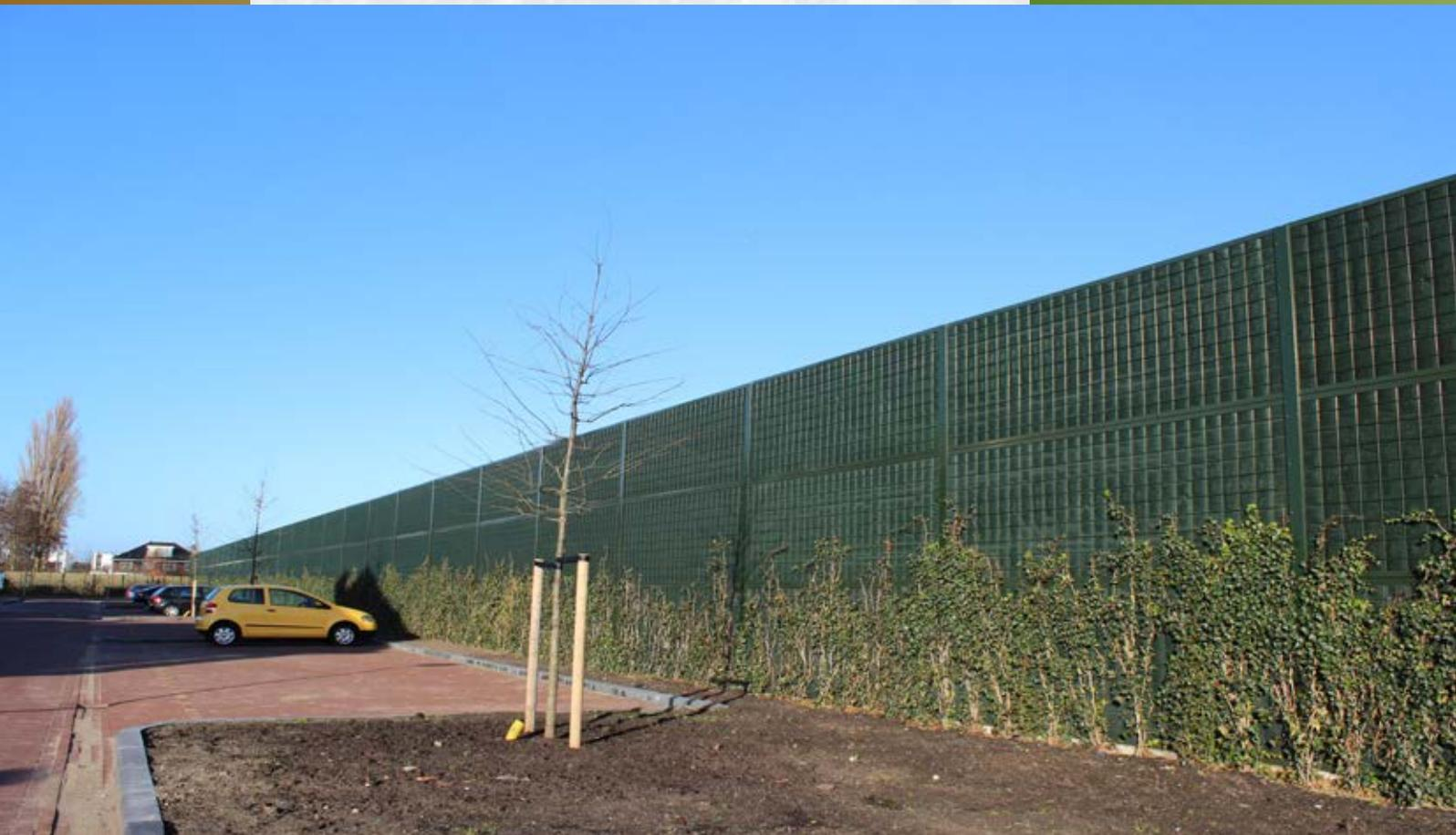
*L'écran antibruit Noise-Reducer® est une construction légère permettant un haut niveau d'isolation et d'absorption. La paroi extérieure de cet écran antibruit est équipée sur un côté, ou des deux côtés, d'une couche de laine minérale absorbante, et est finalisée avec plusieurs couches de treillis métalliques.*
