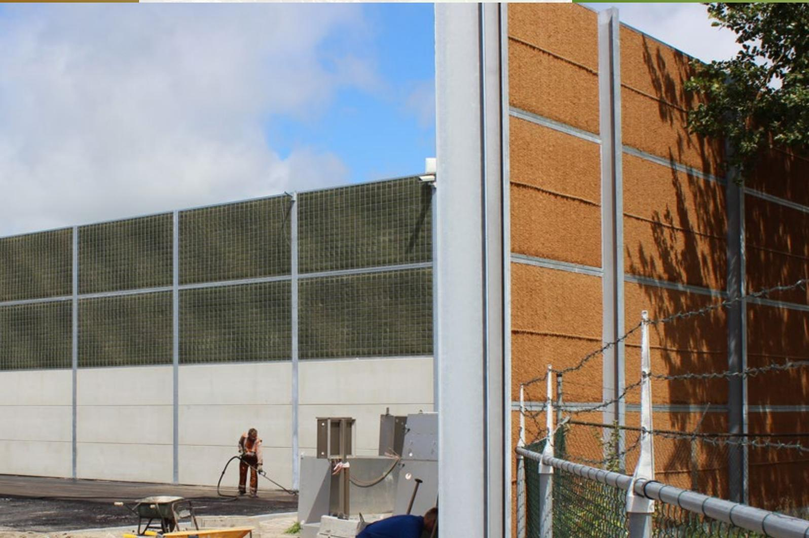
*L'écran antibruit Kokowall® HA-MinWol est doté, sur le côté extérieur, d'une finition en fibre de noix de coco (recouvrable), et sur le côté intérieur, d'une couche absorbante de laine minérale, d'un filet en plastique PE et d'un grillage en acier galvanisé (non recouvrable).*
